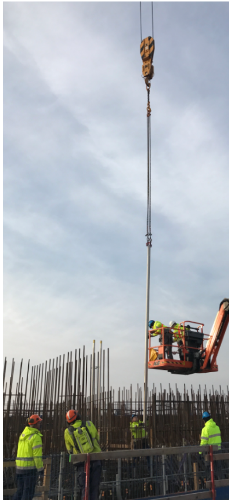
Electrical conduits (April 17)
